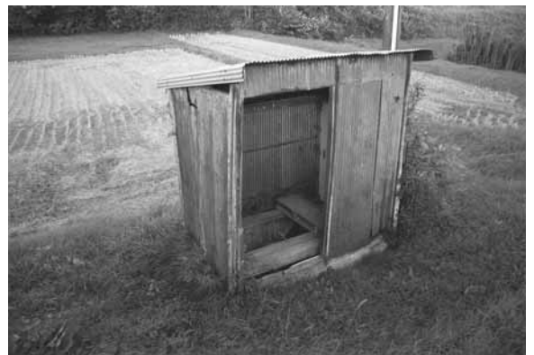
頼りになった揚水機場
