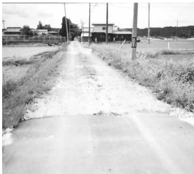
早期整備が望まれる生活道路
