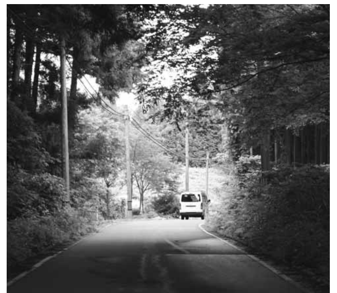
トンネル状態の市道
