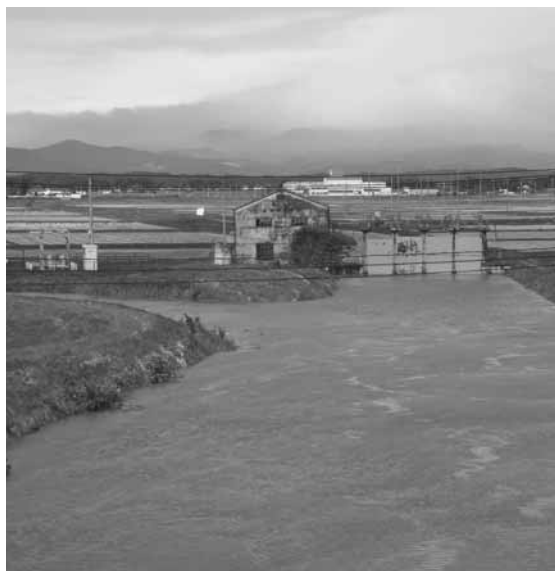
撤去が検討される落堀機場と樋門
