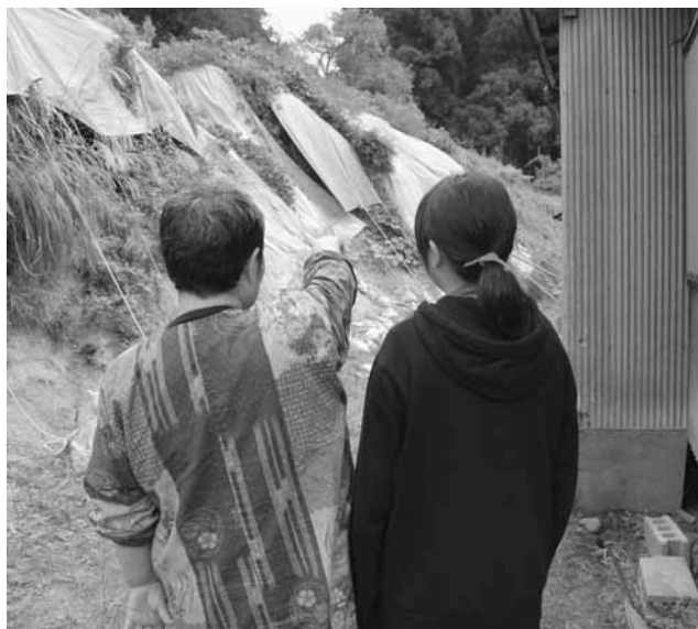
豪雨が心配な裏山の土砂崩れ
