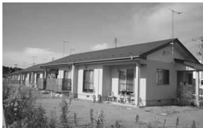
設置対象の上堤住宅（若柳地区）
