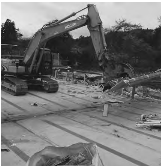
旧文字小学校のプール解体工事
