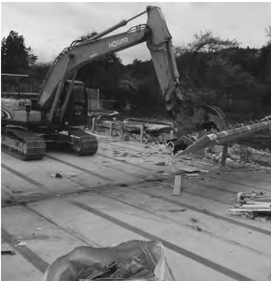
旧文字小学校のプール解体工事
