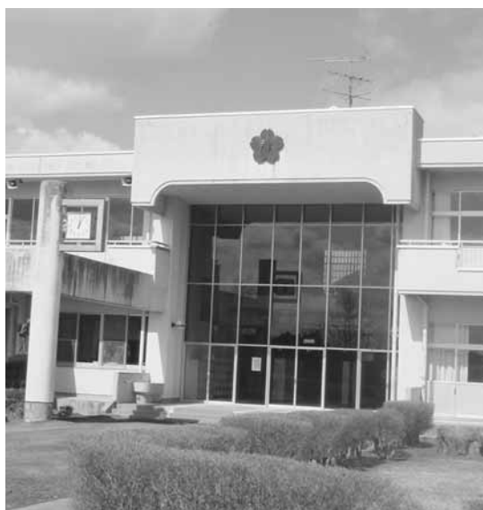
(仮称)北部学校給食センター予定地(旧津久毛小)
