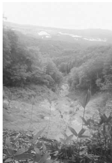
深山嶽候補地付近 (小野松沢崩落個所 平成25年6月)
