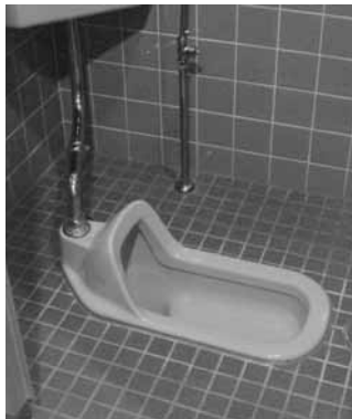
あったかトイレは和式から洋式へ改修
