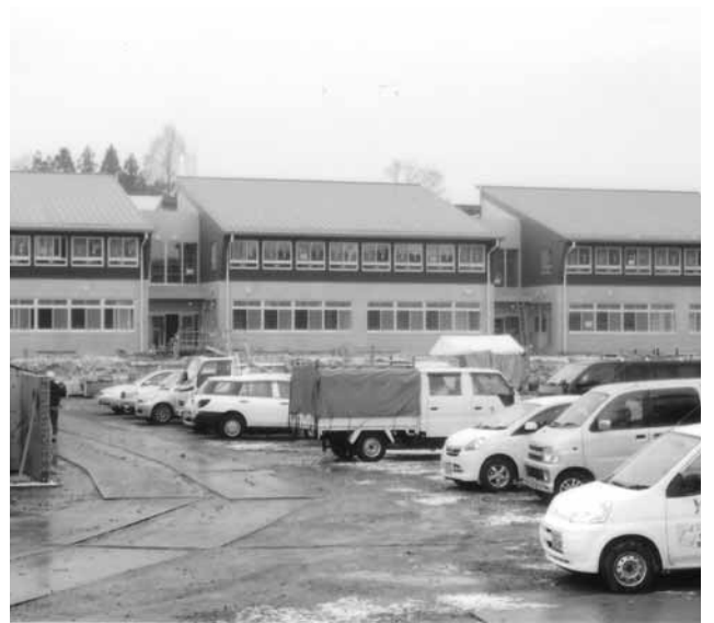
完成間近の(仮称)金成小中一貫校
