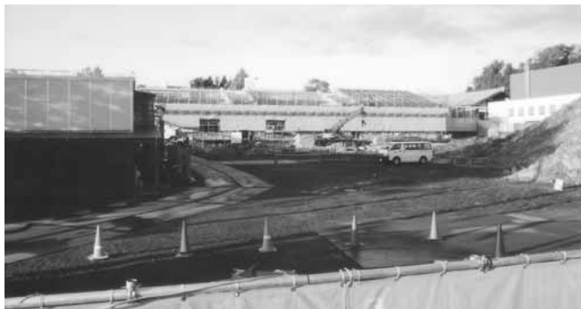
建設工事が進む（仮称）金成小中一貫校
