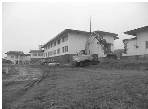
解体工事が進む「旧いこの村栗駒」
