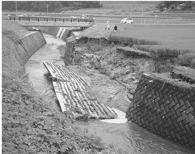
照越川（築館）護岸の崩落現場
