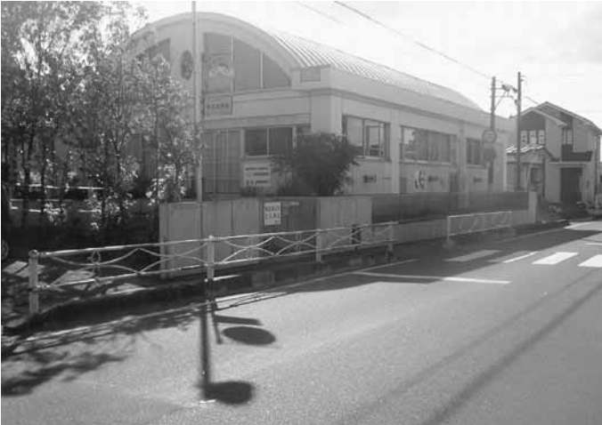
施設整備が予定されている築館幼稚園
