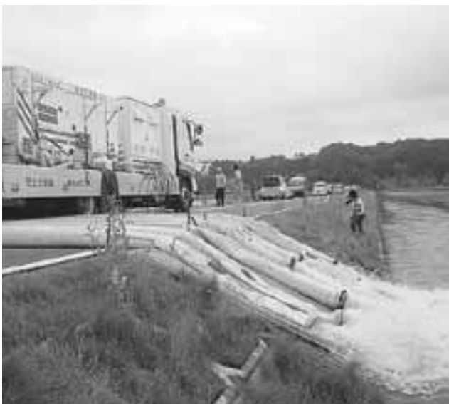
冠水した水田から伊豆沼への強制排水作業
