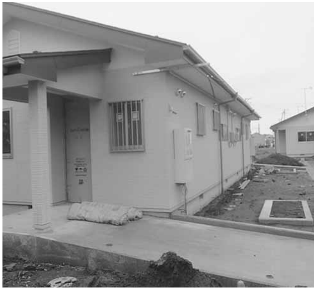
建設中の災害公営住宅（若柳地区）
