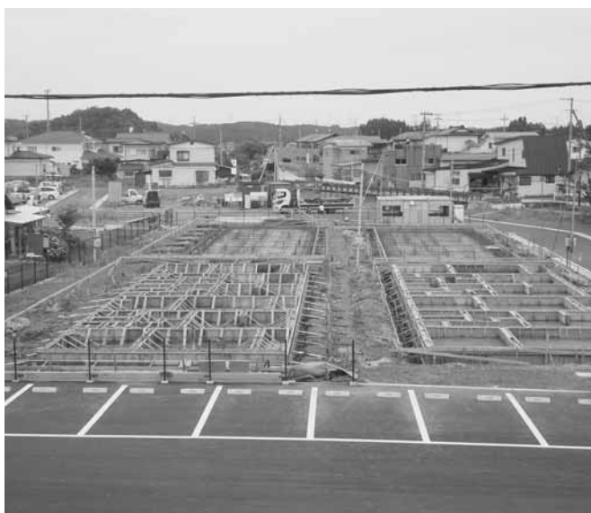
着々と建設が進む八日町住宅（栗駒地区）
