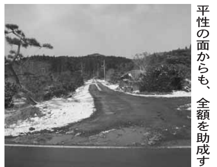
未舗装の生活道路
