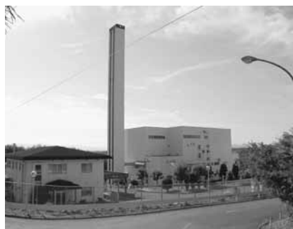
23年経過したクリーンセンター
