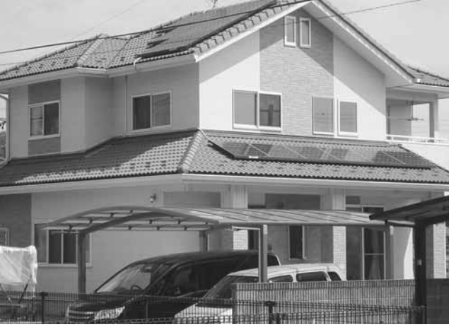
当初予算で設置された太陽光発電設備
