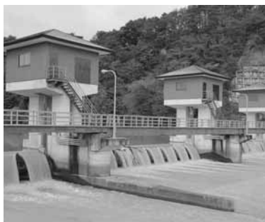
伊豆野堰からの水で試験中
