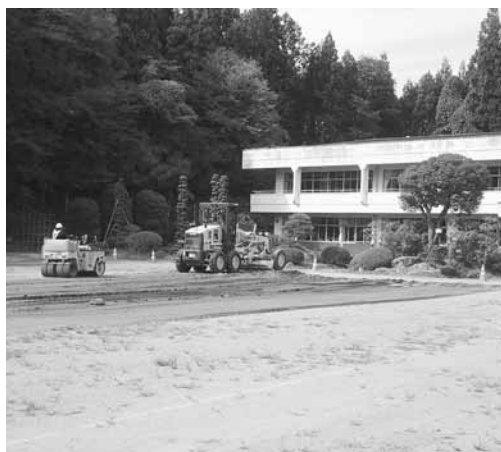
「子どもの安全が第一」放射能の除染作業 (花山小学校)
