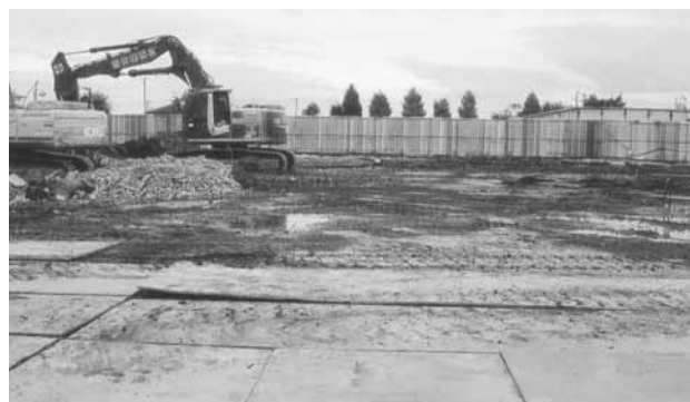
整地された校舎用地
