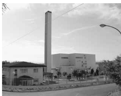
23年経過したクリーンセンター
