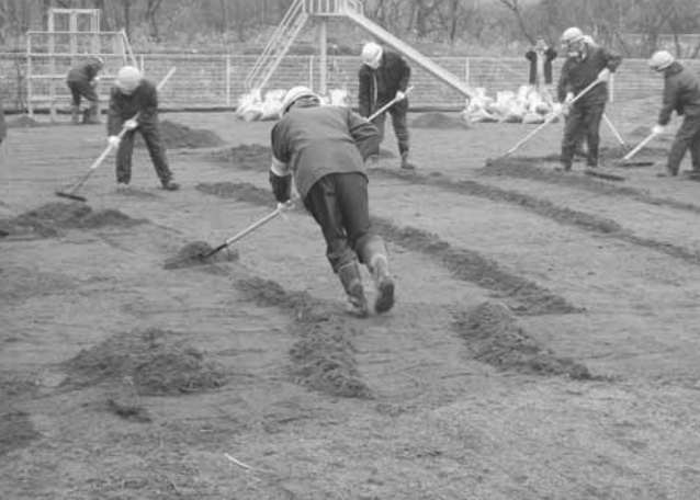
除染実施中の鳥矢崎幼稚園
