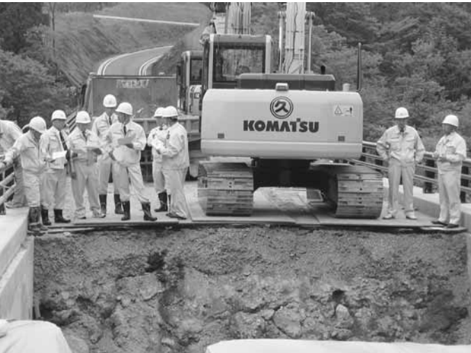
陥没した現場
