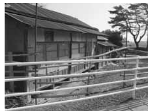
急がれる空き家対策
