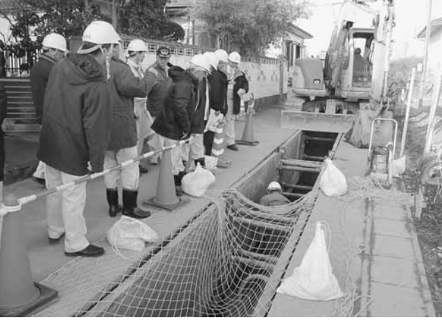
若柳地区の下水道工事
