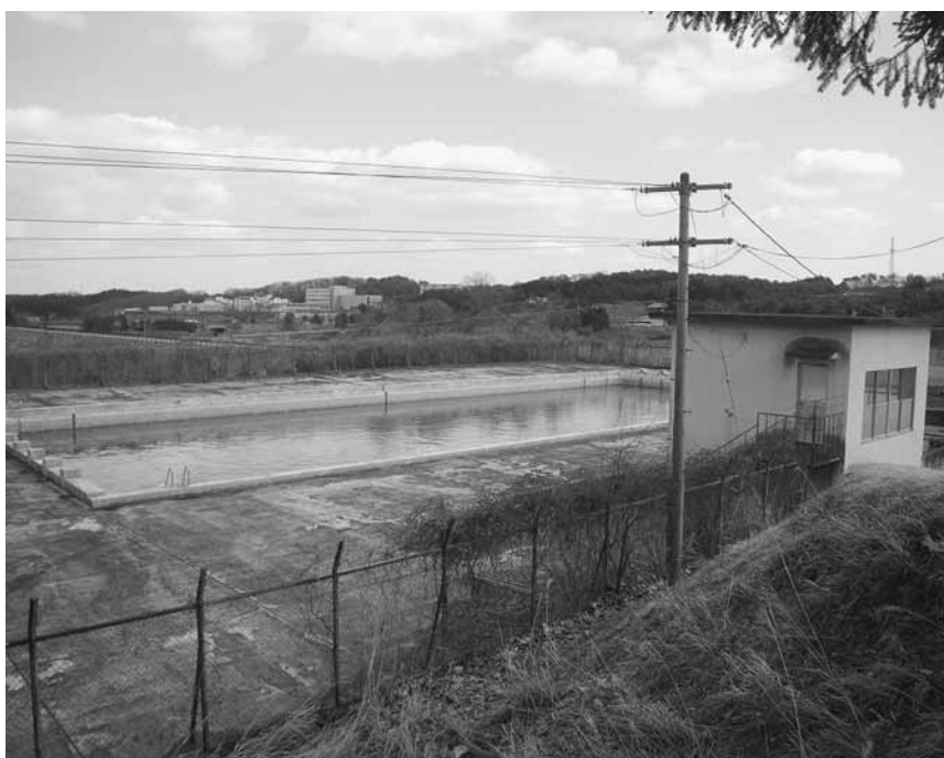
改築される築館中学校プール
