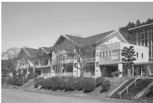
再編により増築される岩ヶ崎小学校（栗駒）
