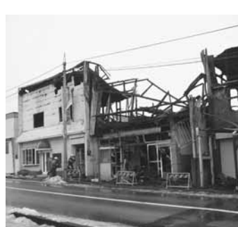
延焼した火災現場
