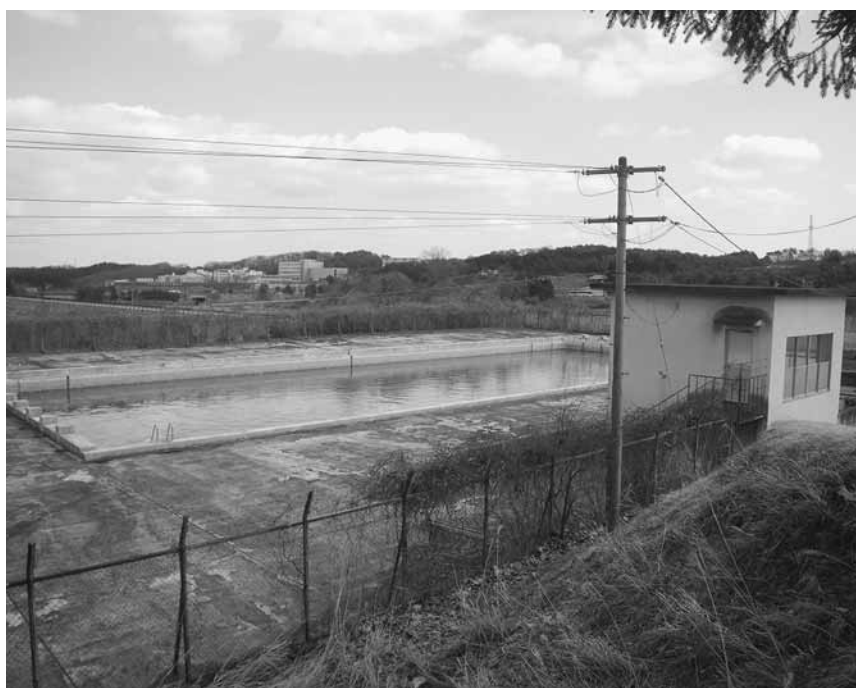
改築される築館中学校プール
