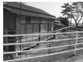
急がれる空き家対策
