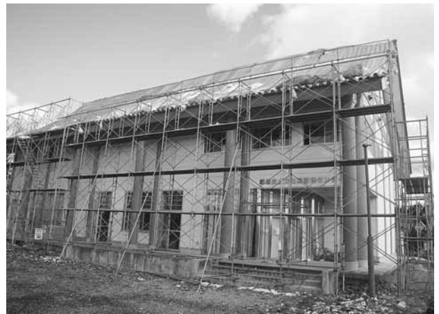
文化財施設災害復旧工事「築館出土文化財管理センター」
