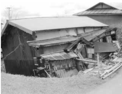
解体撤去が待たれる被害建物
