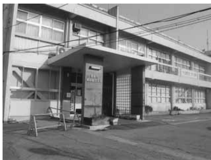
移転が予定されている瀬峰総合支所
