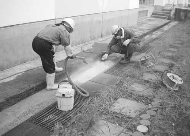
高圧洗浄による除染作業
