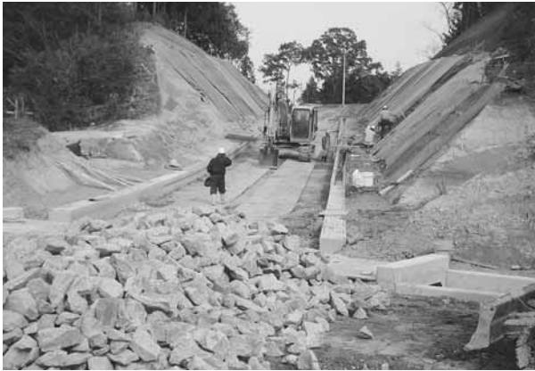
まわたしど 市道間渡戸線道路改良工事（築館）
