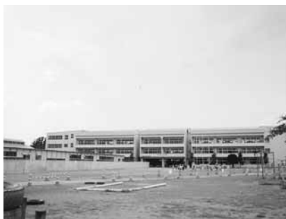
損壊した志波姫小学校と仮設校舎
