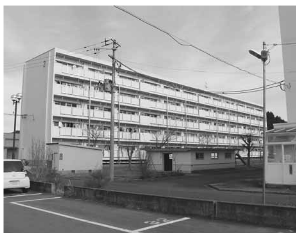
修繕される「(仮称) 定住促進栗駒住宅」
