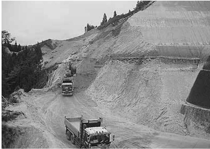
急ピッチで進む復旧作業
