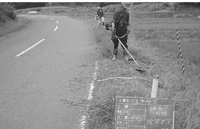
緊急雇用対策での草刈り作業
