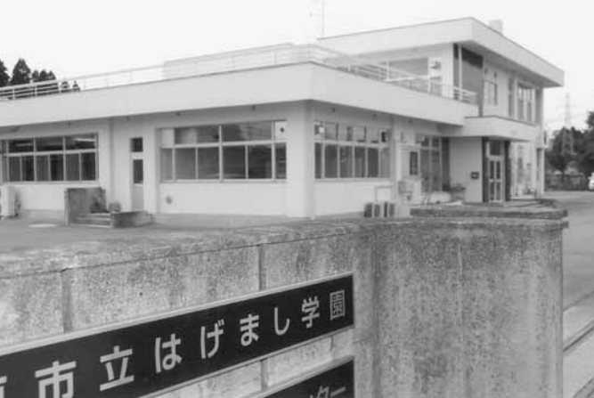
6月頃完成予定の雨漏り補修
