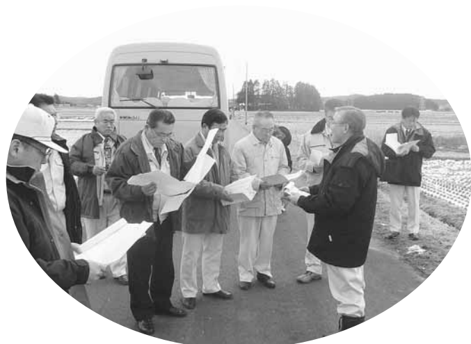
市道舗装の現地説明
