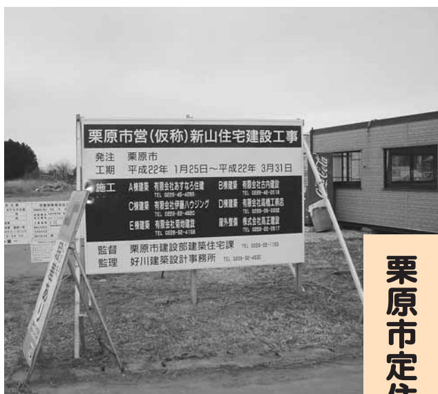
建設が進む新山住宅
