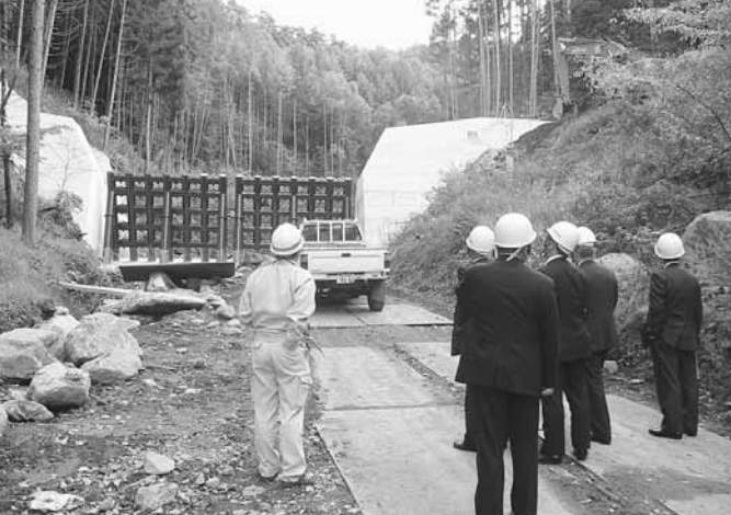
復旧中の「岡谷砂防えん堤」
