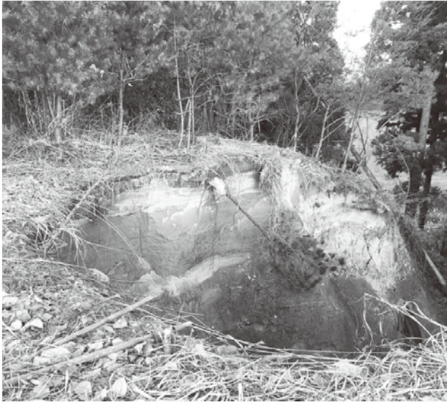
小田ダム湖畔パークゴルフ場付近の法面
