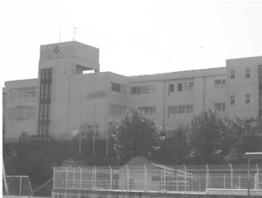
空調設備が設置される小中学校（築館小学校）
