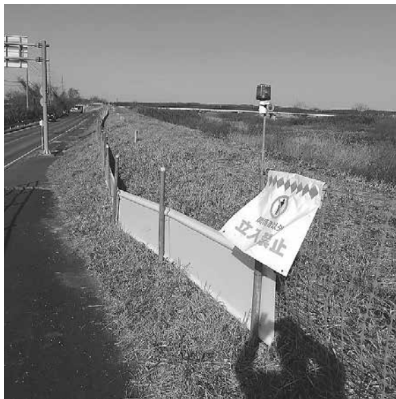
かさ上げ工事がはじまる迫川右岸堤防
