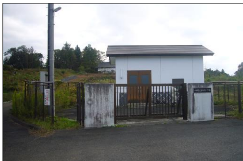
畑岡送水ポンプ場
