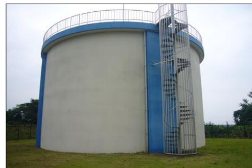
薬師ヶ丘配水池
