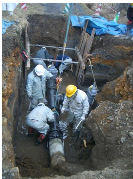
東日本大震災で被災した水道管の復旧工事の様子
