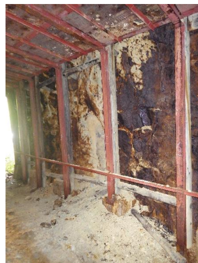
トンネル内部は岩盤が見える
