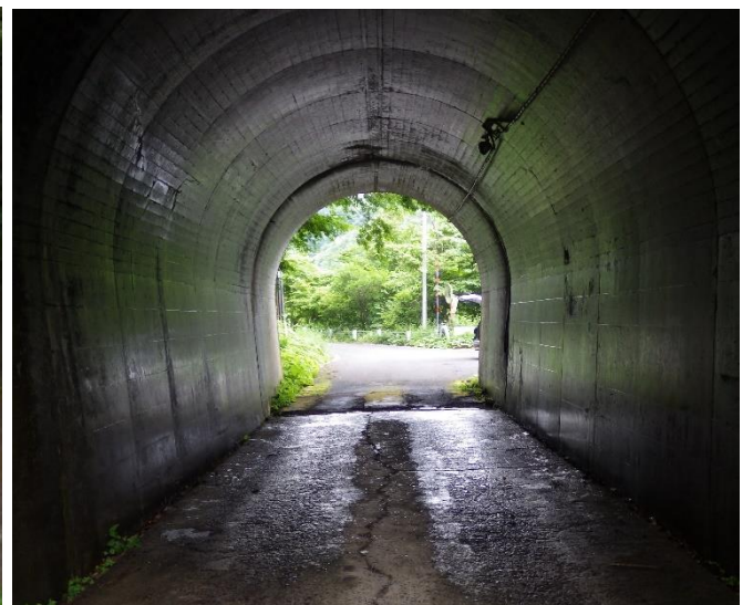
トンネル内はアーチ型のコンクリートで保護
