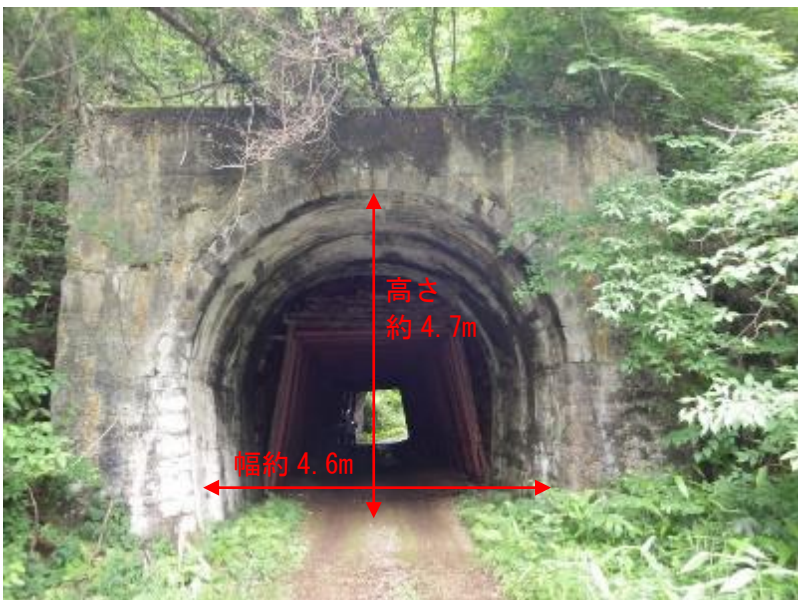
トンネル写真 出入口近くはコンクリートで防護
