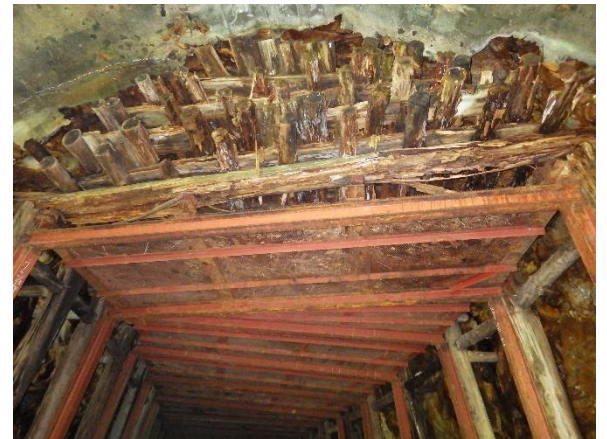
トンネル天井は木材と鋼材で防護
