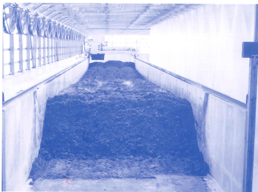
発酵槽及び スcoop式攪拌機
