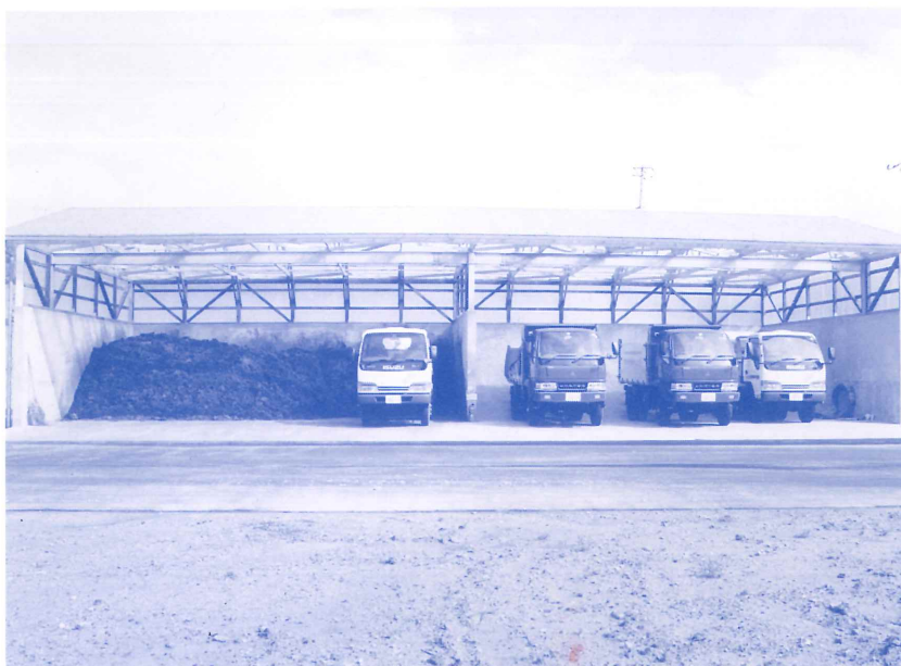
原料・副資材置場
