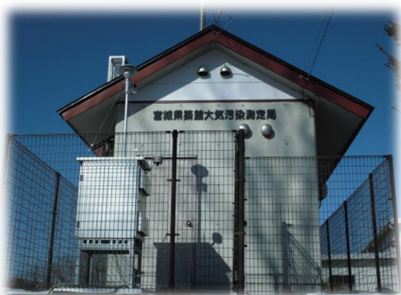
築館大気汚染測定局
