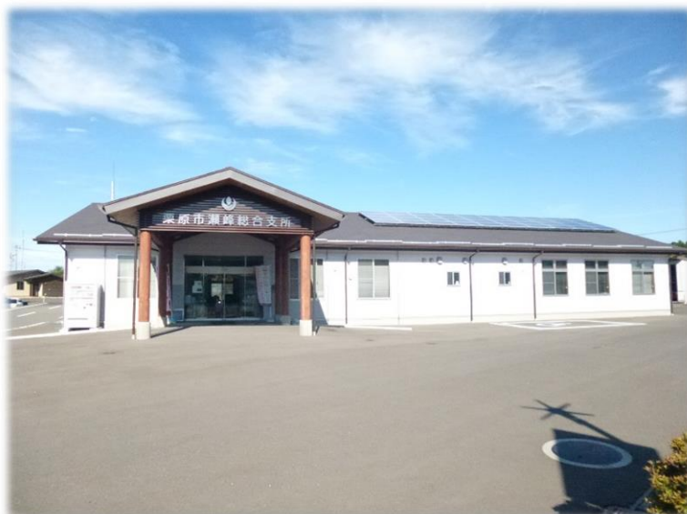
太陽光発電設備（瀬峰総合支所）
