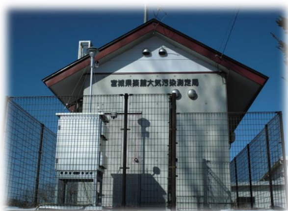
築館大気汚染測定局
