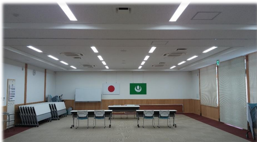
LED照明（一迫総合支所）
