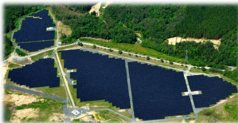
太陽光発電設備（鶯沢細倉地区のメガソーラー）
