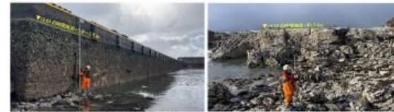
輪島市鹿磯周辺の地盤隆起の状況（左：鹿磯漁港、右：漁港北側の波食棚） 漁港の防波堤は最大3.9m、波食棚の海面高度は3.6m。新しくできた海成段丘となる
