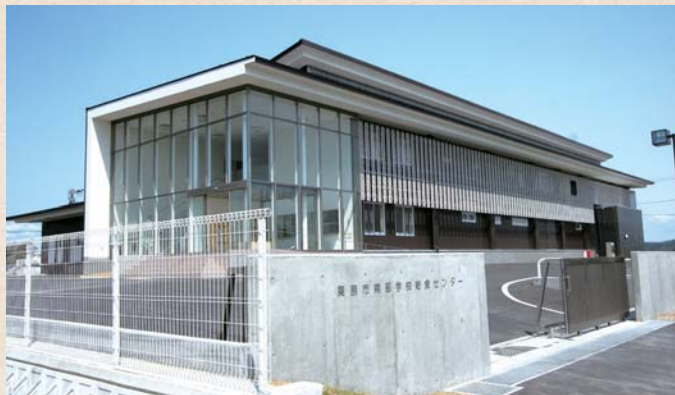
南部学校給食センター完成(5月15日)
