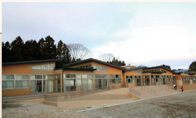
瀬峰小学校新校舎完成(12月15日)
