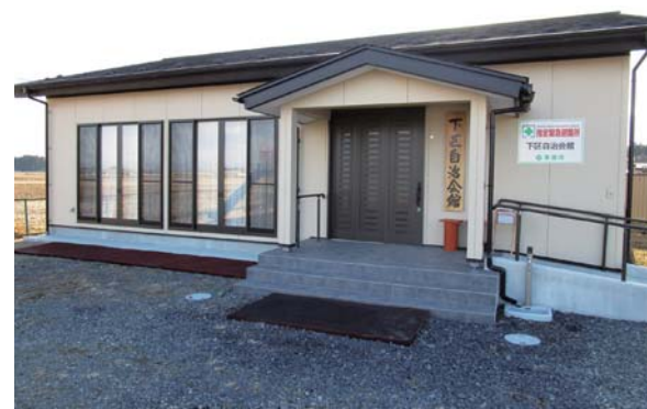
◀改築された自治会館
