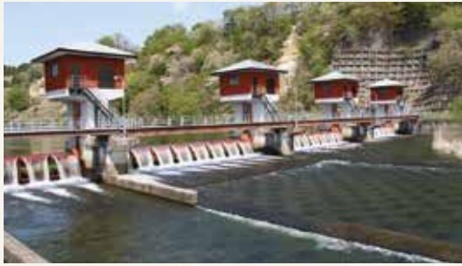
▲伊豆野堰に水を引き込む頭首工（一迫地区）
