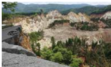
▲市道荒砥沢線の崩落
