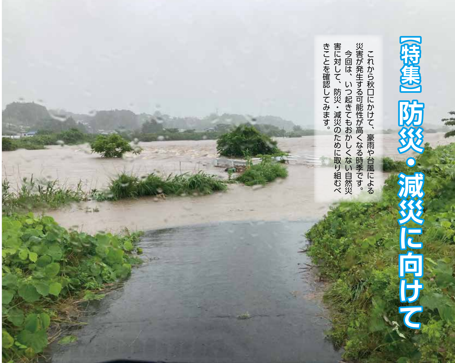
▲令和4年7月の大雨で増水した小山田川によって水没した道路
