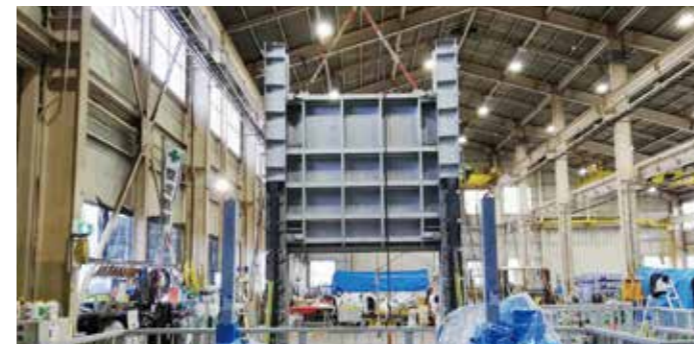
▲組立作業中の水門設備
