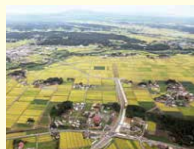
▲上空から見た国道4号築館バイパス
