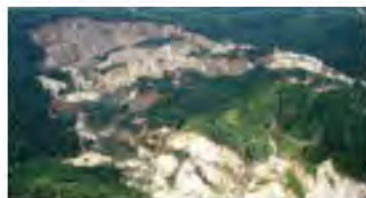
▲日本最大級の荒砥沢ダム上流部の地すべり
