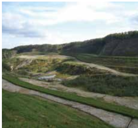
▲栗駒地区耕英の冷沢崩落地
