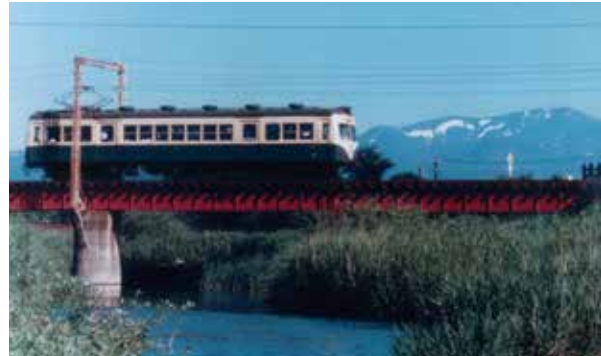
左/昭和40年ころの鶯沢地区の二迫川鉄橋を走るM18形
